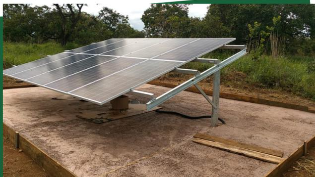
Instalado pela Emater-DF, o sistema de energia fotovoltaica escolhido foi o off-grid, ou seja, não conectado à rede da concessionária. Por meio de um complexo sistema de condução que, utilizando a energia do sol e uma bomba convencional, capta água do córrego próximo ao assentamento e leva até os reservatórios de cada uma das propriedades. Os reservatórios são revestidos por uma geomembrana (um tipo de lona profissional de impermeabilização).
